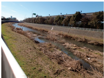
図 9 新鶴嶺橋-中原橋間 (No. 5)
