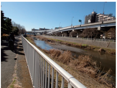
図 10 中原橋-中原橋下流親水 スペース間 (No. 6)
