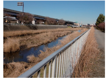
図 8 浜園橋-新鶴嶺橋間 (No. 4)
